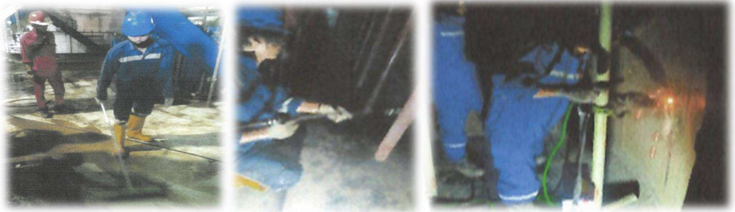
Pemeliharaan Heat Exchanger PLTU
