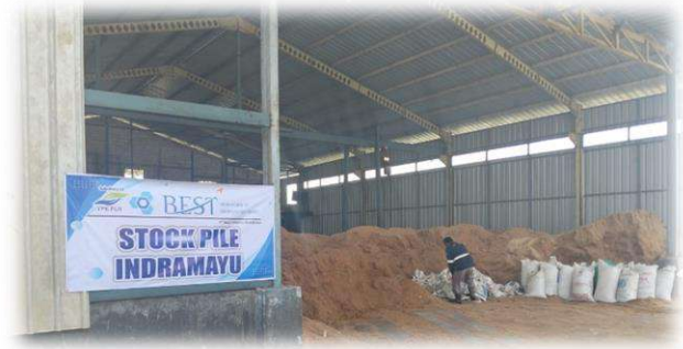
Fasilitas Blending dan Drying UV Indramayu
